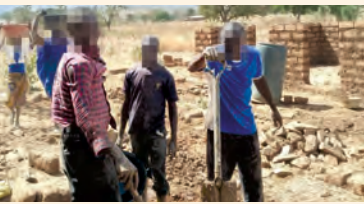
Das Team unseres Projektpartners baut mit verfolgten Christen einen Brunnen.
